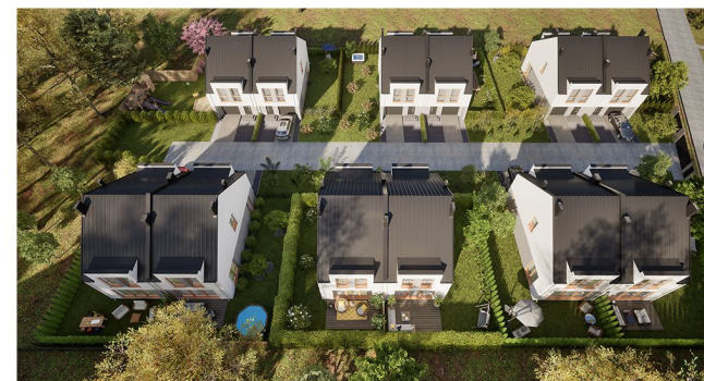
Widok budynku z lotu ptaka
