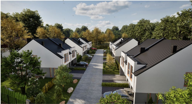
Widok budynku od strony ulicy
