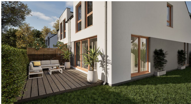
Widok budynku od strony działek
